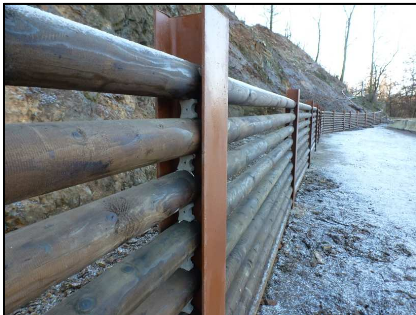
Obr. č. 3 – Příklad podélného distancování dřevěné kulatiny.
